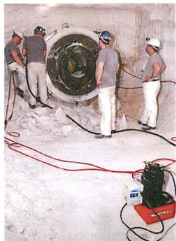
Vier hydraulische Pumpen werden angeschlossen. Sie sollen durch Abdrücken vom Salz die Segmente voneinander lösen.
