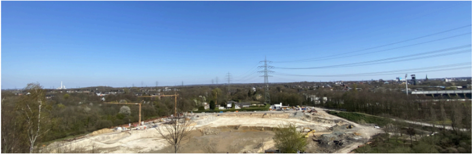
Kanalbau am Wattenscheider Bach macht Fortschritte
