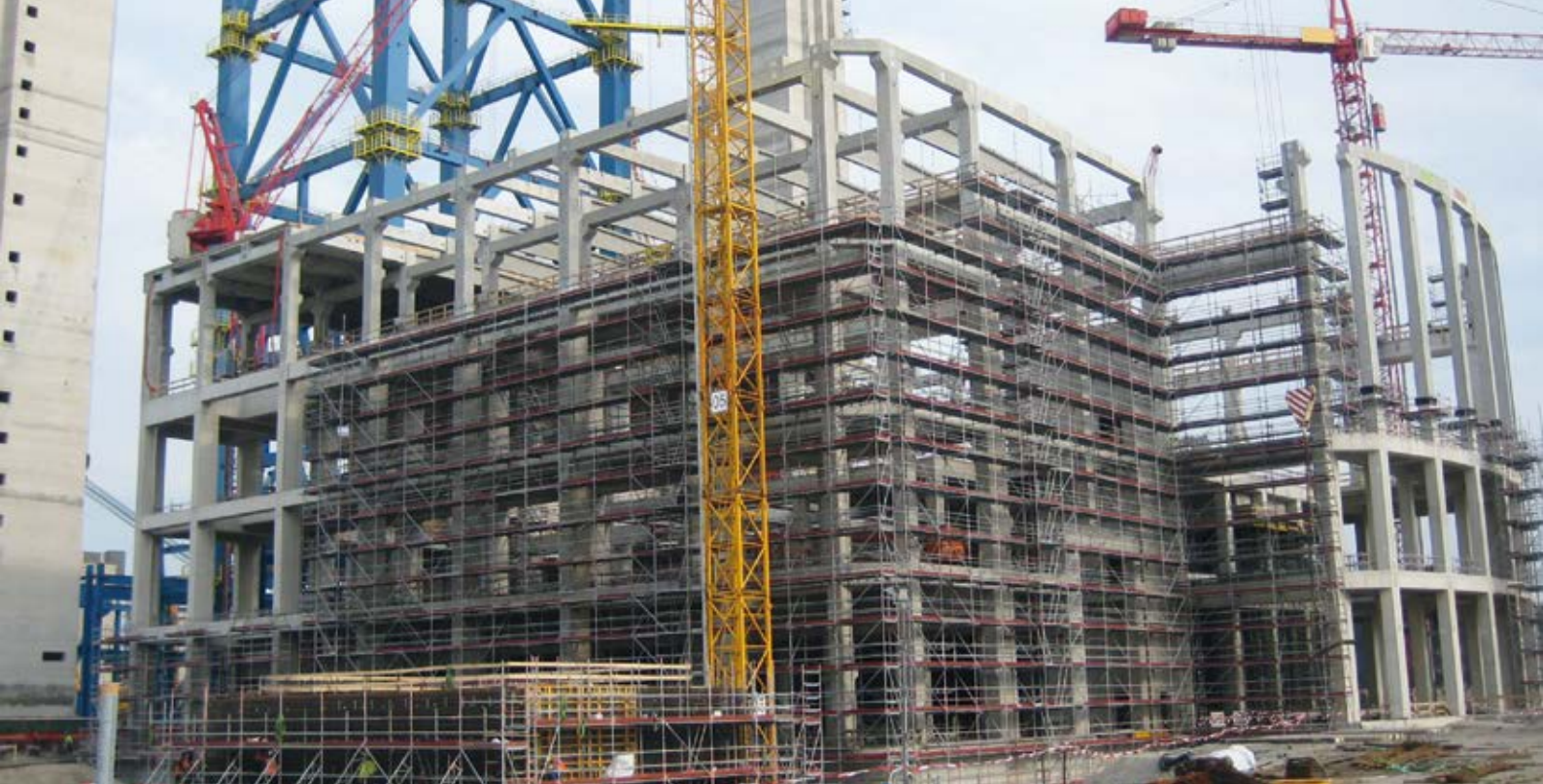
Beim Kohlekraftwerk Datteln beschleunigte BBM die Rohbauphase durch eine optimierte Kranauslastung und Umsetzung eigener Schalungskonzepte. For the Datteln power plant, BBM accelerated the carcassing stage through optimized crane utilization and proprietary formwork concepts.
