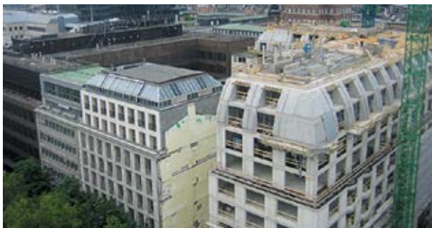
Die Rohbauarbeiten an diesem Objekt wurden in Deckelbauweise ausgeführt.
