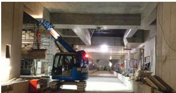
BBM führte die Rohbauarbeiten an zwei U-Bahn-Haltestellen der Düsseldorfer Wehrhahnlinie aus. BBM performed the carcassing work at two subway stations of the Düsseldorf Wehrhahn Line.
