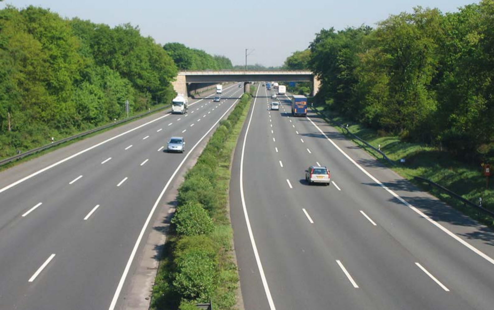
Diese Eisenbahnbrücke über die Autobahn A2 wurde über dem fließenden Verkehr abschnittsweise erstellt. This railroad bridge crossing Autobahn A2 was completed in sections above moving traffic.
