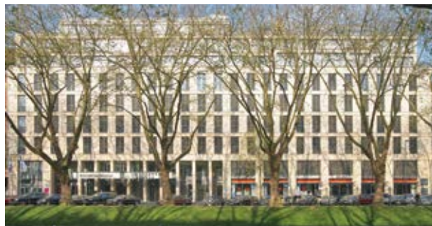
BBM errichtete fünf Untergeschosse des Hotels mit zwei Meter dicken Stahlbetonbauteilen und wasserundurchlässigem Beton. BBM built the five-story basement using reinforced concrete elements of two-meter thickness and water-impermeable concrete.
