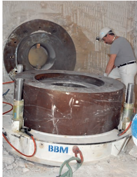
Der Koloss ist gefallen. Die Hydraulikpumpen fahren langsam zurück.
