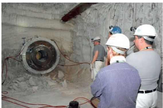
Gespanntes Warten in sicherem Abstand.
